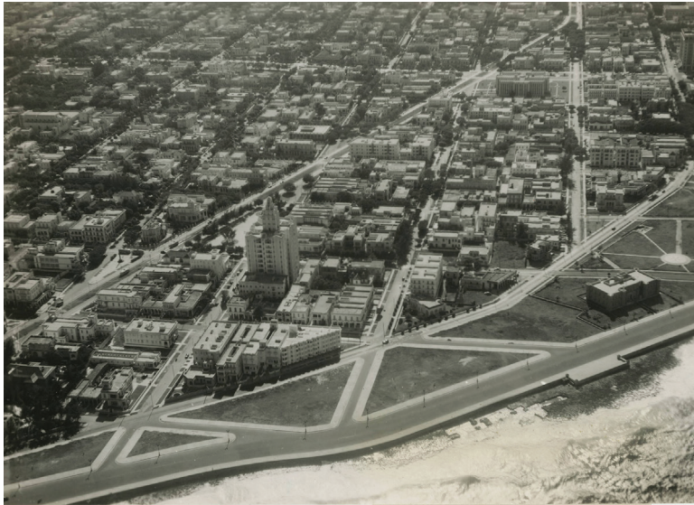
Figura 3 Homogeneidad en altura de El Vedado aún en la década de 1940. En primer plano, el edificio López Serrano, el más alto entre 1932 y 1954.
